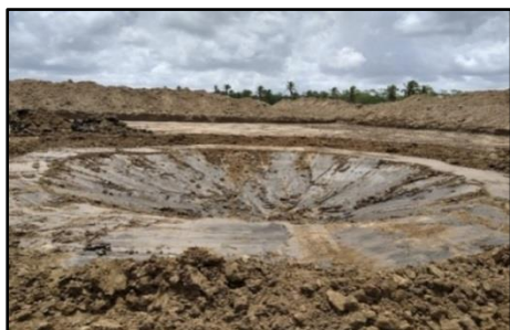
Foto 101 – Construção de um dreno central do tipo “toilets” Fonte: MCR Aquacultura - 2020.
