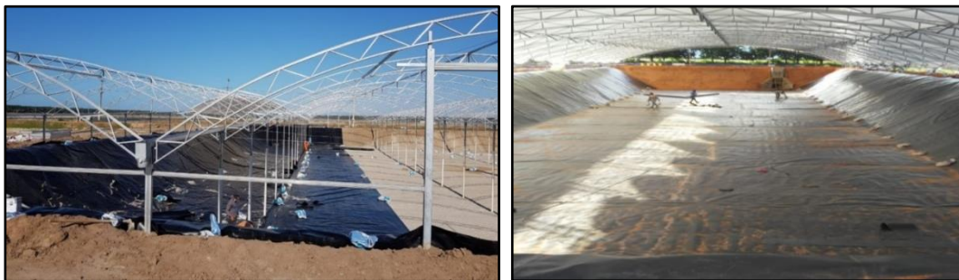
Fotos 99 e 100 – Aplicação de geomembrana em PEAD Fonte: ABCC.
