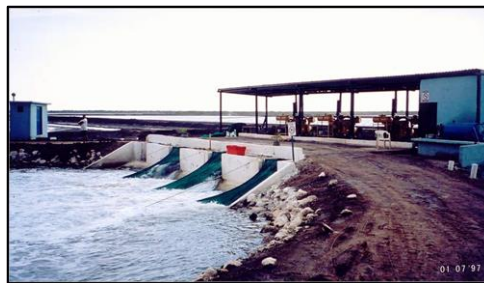
Fotos 73 e 74 – Filtragem primária no canal de abastecimento de fazenda de camarão Fonte: LIMA, Marcelo - 2006.
