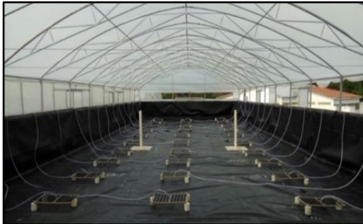
Foto 107 – Distribuição de aeração vertical com mangueiras microporosas de baixa pressão “em viveiros intensivos” Fonte: MCR Aquacultura - 2017.
