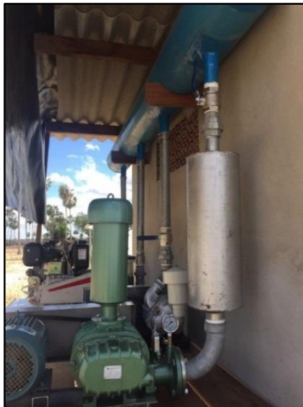
Fotos 109 a 111 – Sopradores e compressores para distribuição de ar em mangueiras microporosas de baixa pressão em viveiros intensivos Fonte: ABCC - 2020.
