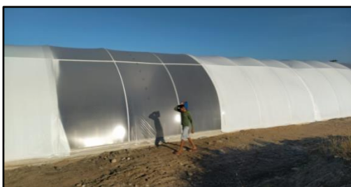
Foto 42 – Tanques berçários secundários com uso de estufas para controle de temperatura Fonte: ABCC - 2020.
