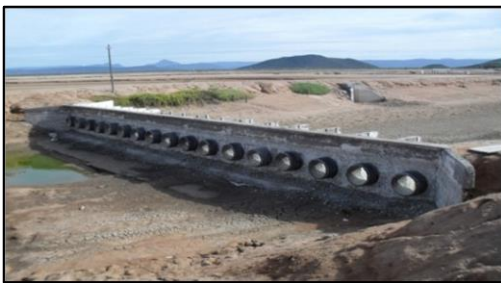
Fotos 73 e 74 – Filtragem primária no canal de abastecimento de fazenda de camarão Fonte: LIMA, Marcelo - 2006.
