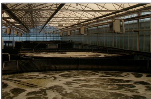
Foto 43 – Sistema de cultivo de camarão com uso de bioflocos Fonte: FURG, 2012; SCOPEL, Bruno, 2013.
