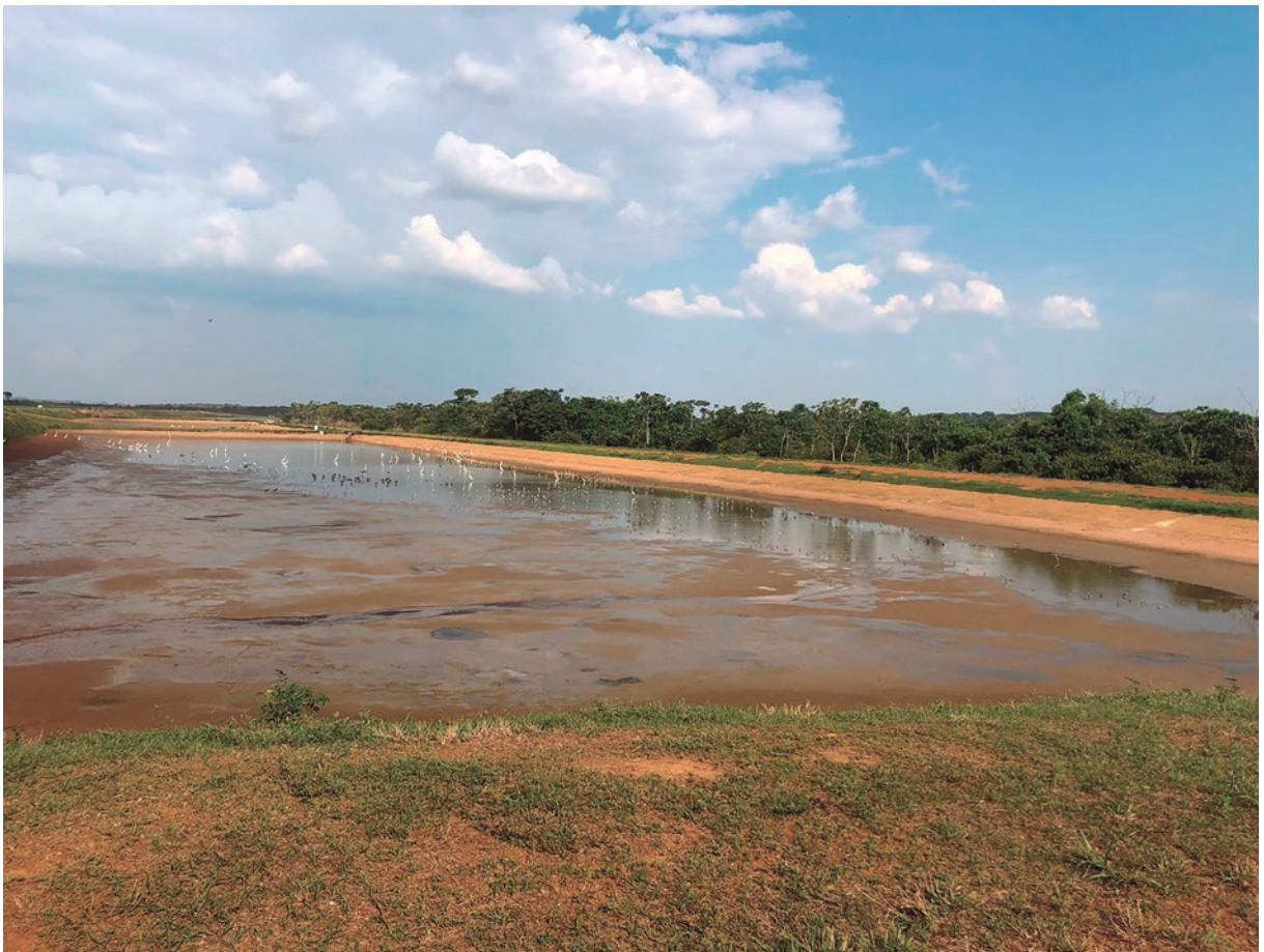
FIGURA 4 Tanque após o vazio sanitário, em processo de enchimento
