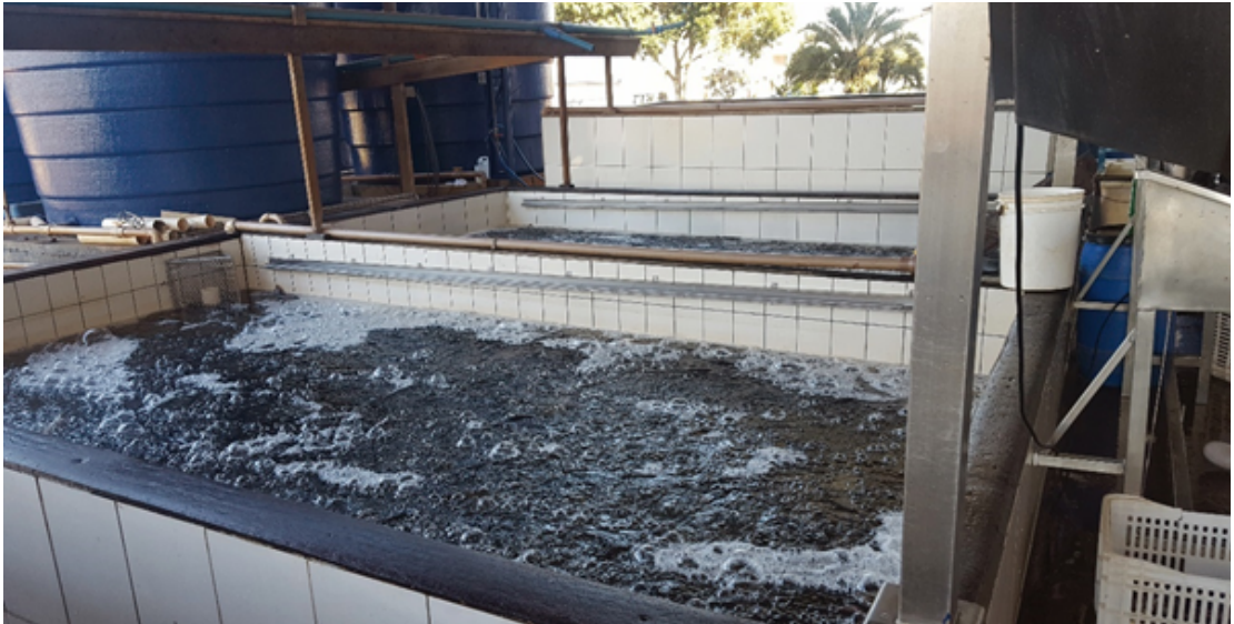
FIGURA 2.3 - Tanques de recepção/depuração no frigorífico com sopradores de ar
