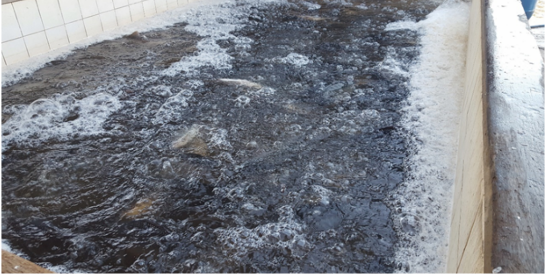
FIGURA 2.2 - Detalhe de um tanque de recepção/depuração no frigorífico
